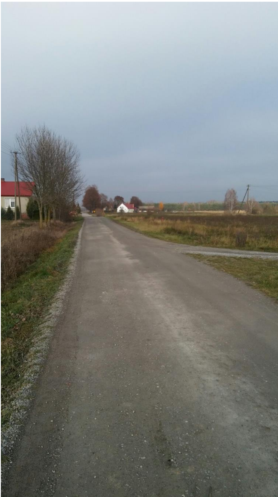
Rysunek 9 Miejsce montażu słupa oświetleniowego solarno-wiatrowego (przykład)
