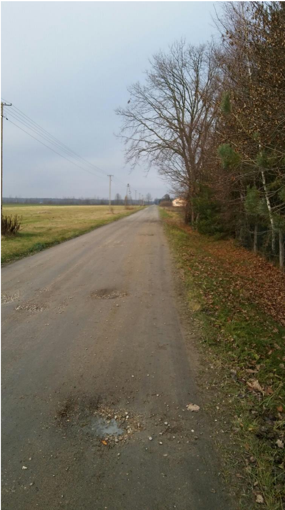
Rysunek 4 Miejsce montażu słupa oświetleniowego solarno-wiatrowego (przykład)
